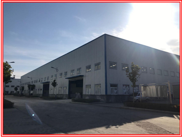
生产车间现状
