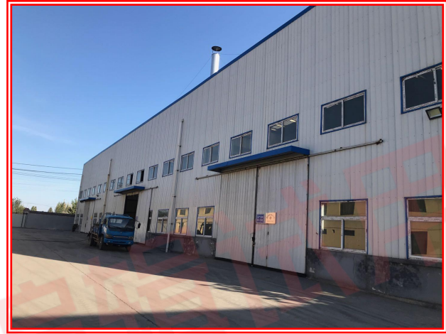
生产车间现状
