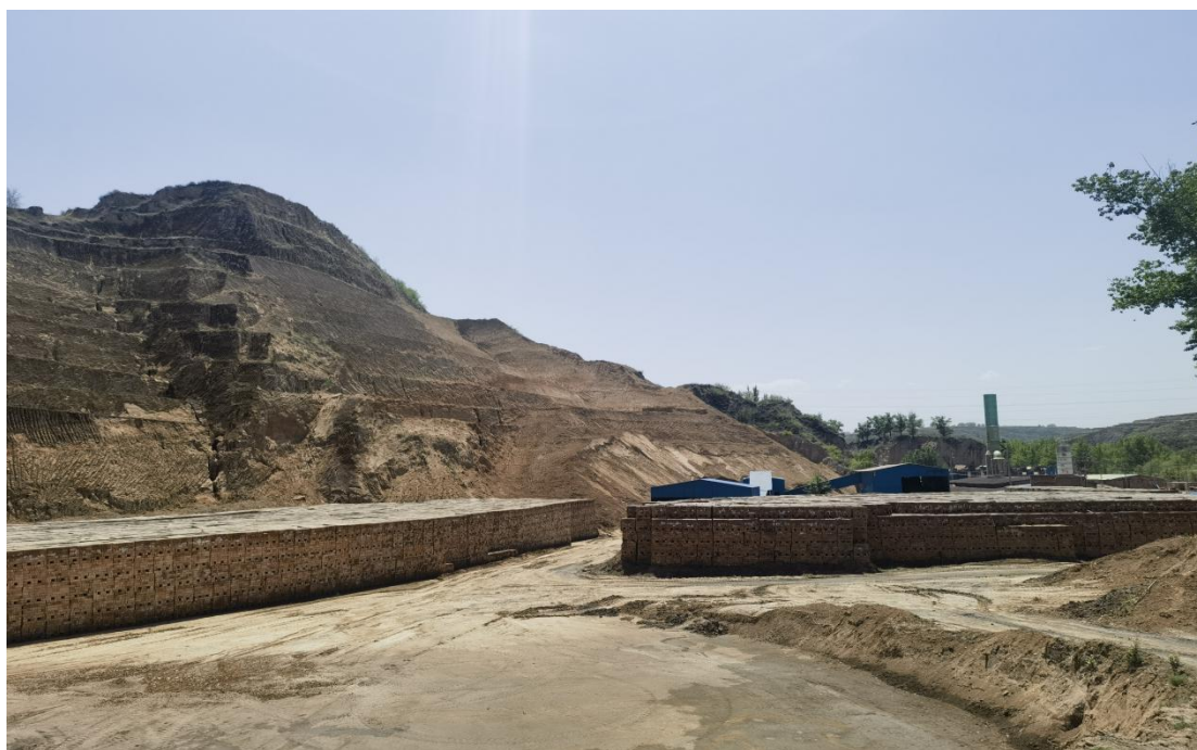
图片 8-2-3 已损毁露天采场（部分）
