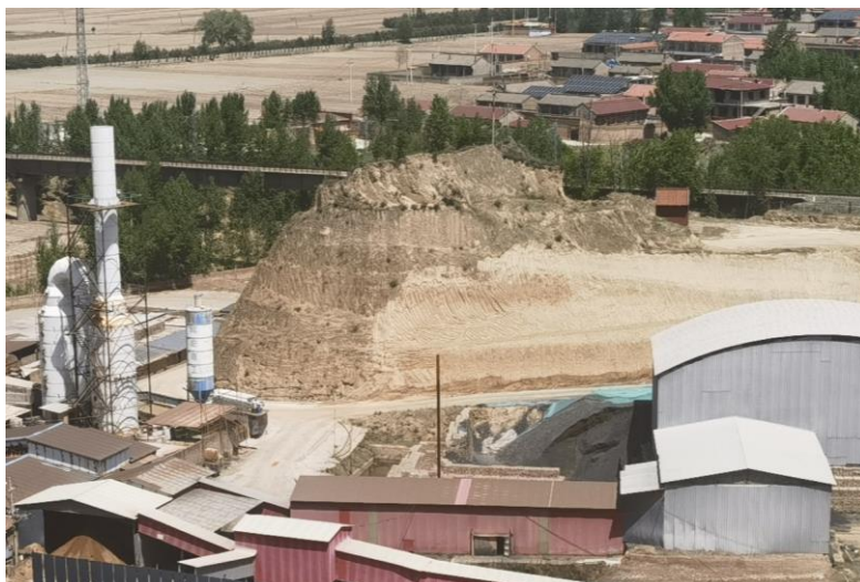
照片 8-3 W3 挖方边坡(镜向 N)
