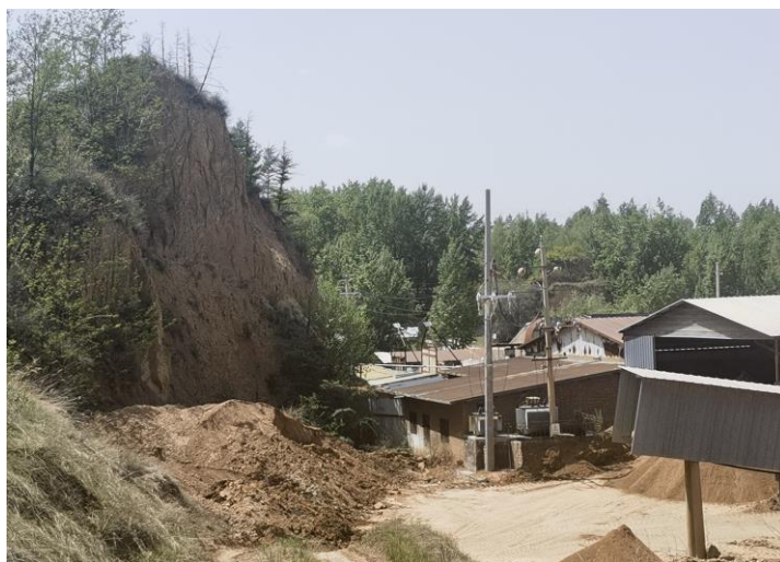
照片 8-2 W2 挖方边坡(镜向 SW)
