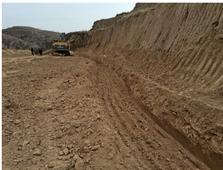
照片 1-4-1 露天采场 1230m 平台排水沟
