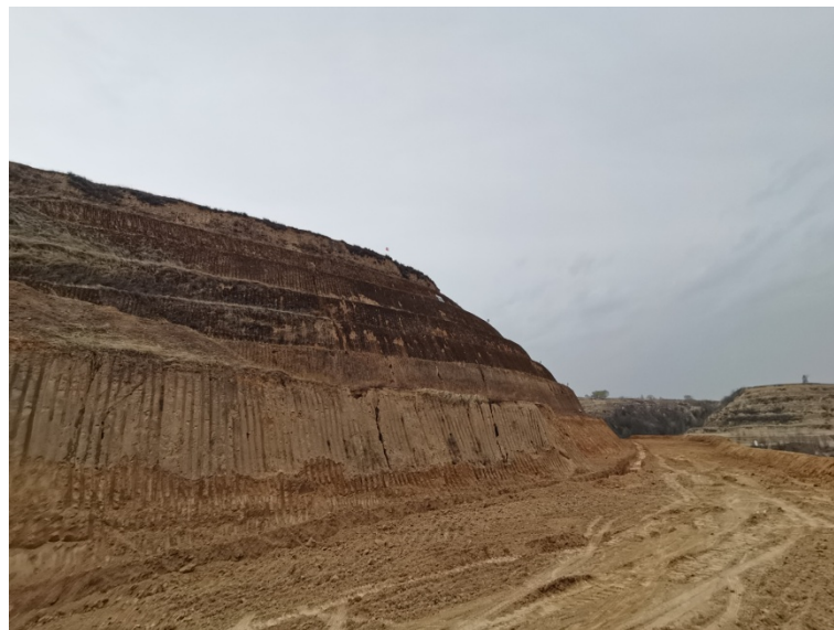
照片 8-2-1 已采场边坡
